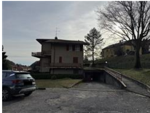
Immobile sito a Colle Brianza (Lecco) in via Lecco n. 1A
